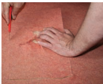
Obr. 2,3,4 Oříznutí poškozené části
