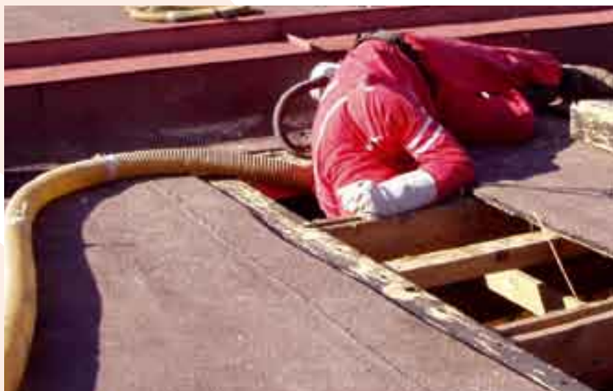
Práce montéra - zafoukání izolace do dutiny
