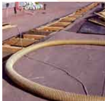
Hadice na střeše
