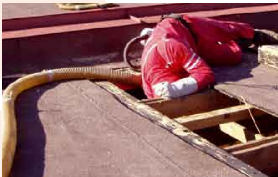
Práce montéra - zafoukání izolace do dutiny
