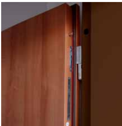
Závěsová část bezpečnostní dveří.
