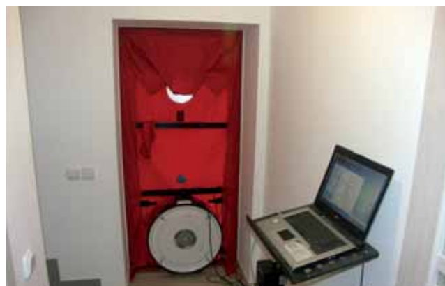
Obr. 4: Měřením těsnosti tzv. Blower Door testem se zjistí kolik vzduchu uniká netěsnostmi. Případné defekty lze najít a utěsnit. (Zdroj Radion)
