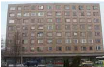
Před rekonstrukcí rok 2002.
